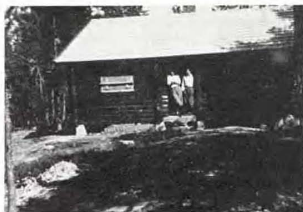
Bilde tatt fra nordvest sommeren '46 før arbeidet med byggetrinn I ble påbegynt. Man skimter ned til venstre restene etter gamlebadstuen.
